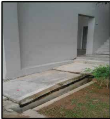
Regangan antara apron dan longkang di Blok Pentadbiran disebabkan mendapan tanah.
