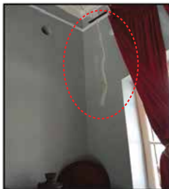
Menunjukkan keretakan dinding di bahagian bawah laluan tingkat atas
