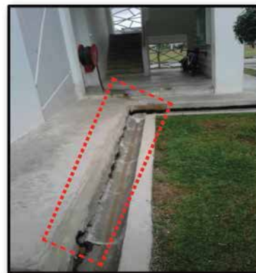
Mendapan pada struktur longkang perimeter dan struktur apron di asrama lelaki (Casa 1)
