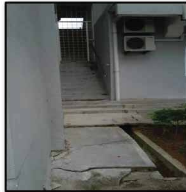
Regangan antara apron dan longkang di Blok Pentadbiran disebabkan mendapan tanah.
