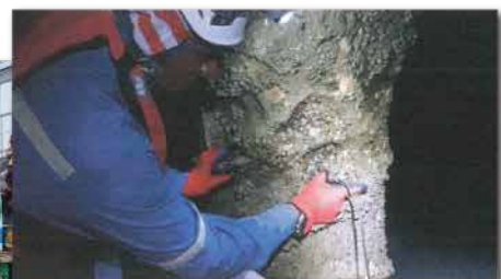
Ultrasonic Thickness Testing (UTTS) adalah bagi menentusahkan ketebalan steel pipe pile.
