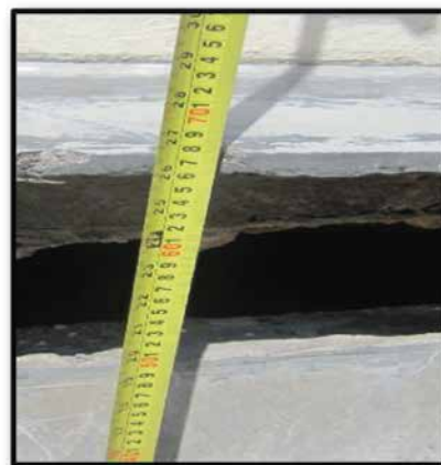
Longkang perimeter telah runtuh kesan daripada mendapan tanah di Blok D (sisi kanan). Magnitud mendapan sehingga 660 mm di sisi kanan Blok D.
