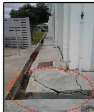
Kerosakan pada struktur apron, longkang dan saluran turun air hujan (RWDP) menyebabkan air meresap ke dalam tanah melemahkan struktur tanah tersebut.
