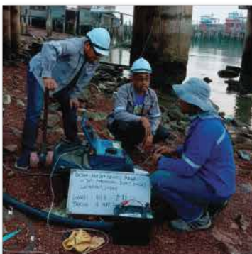
Parallel Seismic Test bagi menentusahkan panjang cerucuk.
