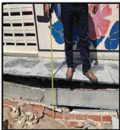
Longkang perimeter telah runtuh kesan daripada mendapan tanah di Blok D (sisi kanan). Magnitud mendapan sehingga 660 mm di sisi kanan Blok D.
