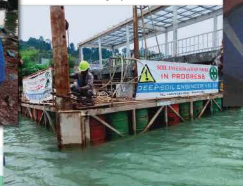
Jack Up Pontoon bagi platform sementara untuk menempatkan mesin penyiasatan tanah.
