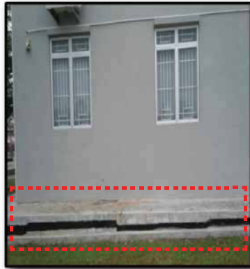
Mendapan pada struktur longkang perimeter dengan magnitud 110mm-120mm.
