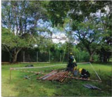
Pemantauan Deep Boring (kawasan rata)
