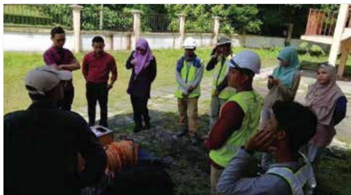
Penerangan ringkas oleh wakil kontraktor berkaitan kerja Electric Resistivity
