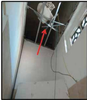
Menunjukkan pengaratan besi tetulang papak atas (slab) kawasan jemuran.
