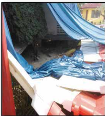
Mendapan tanah akibat lubang benam yang telah berlaku di Blok D, SMK.Kg.Dato' Ahmad Said (sisi kiri).
