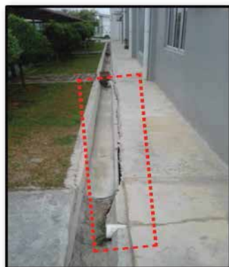
Kerosakan pada struktur apron, longkang dan saluran turun air hujan (RWDP) menyebabkan air meresap ke dalam tanah melemahkan struktur tanah tersebut.
