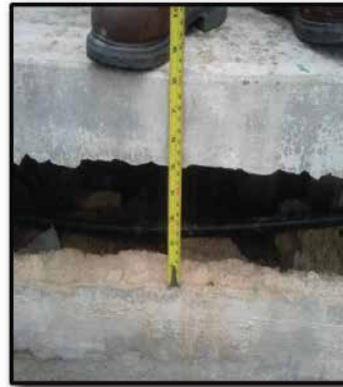
Mendapan pada struktur longkang perimeter dengan magnitud 110mm-120mm.
