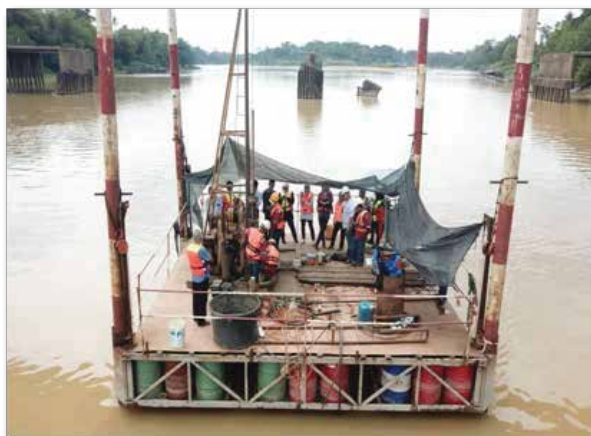
Kerja deep boring menggunakan kaedah jack-up pontoon
