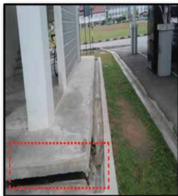
Mendapan pada struktur longkang perimeter dan struktur apron di asrama lelaki (Casa 1)
