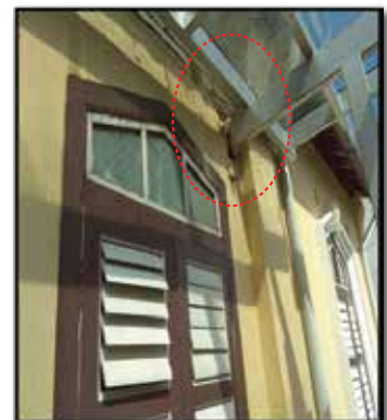
Pengaratan besi tetulang papak atas (slab) kawasan jemuran.
