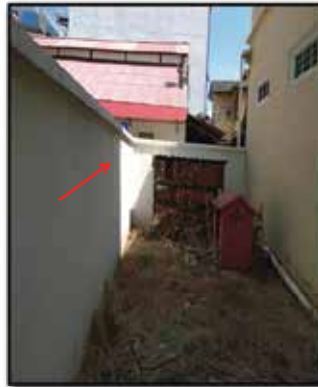
Keretakan-keretakan pada tembok pagar.
