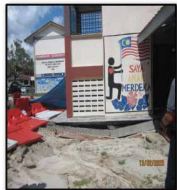
Mendapan tanah akibat lubang benam yang telah berlaku di Blok D, SMK.Kg.Dato' Ahmad Said (sisi kiri).
