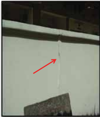
Keretakan-keretakan pada tembok pagar.
