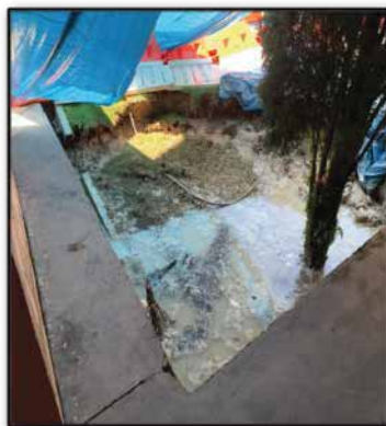
Mendapan tanah akibat lubang benam yang telah berlaku di Blok D, SMK.Kg.Dato' Ahmad Said (sisi kiri).
