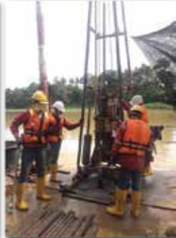
Pemantauan Deep Boring (di atas jack-up pontoon)
