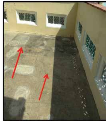
Menunjukkan pengaratan besi tetulang papak atas (slab) kawasan jemuran.
