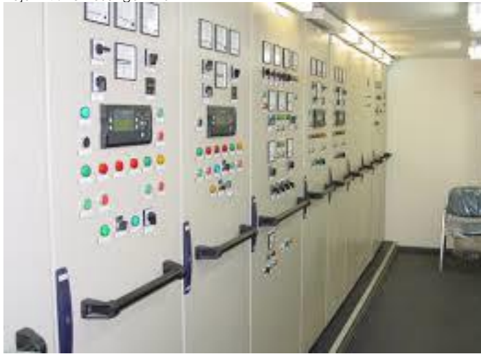
Rajah 17: Pemasangan MSB
