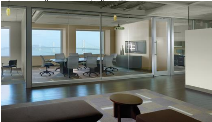
Rajah 22: Dinding sesekat dalam yang menggunakan kaca lutsinar
