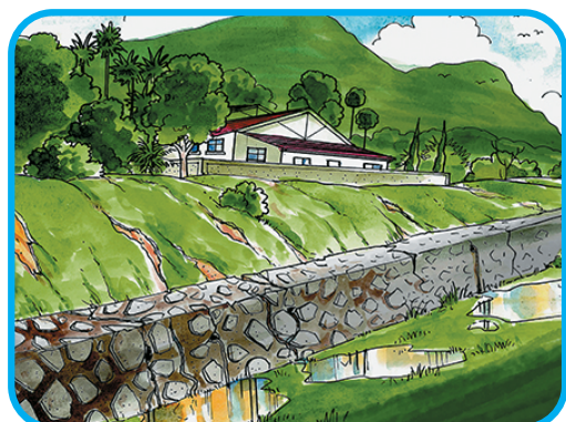
2. 斜坡出现新的水渗透地面现象。
