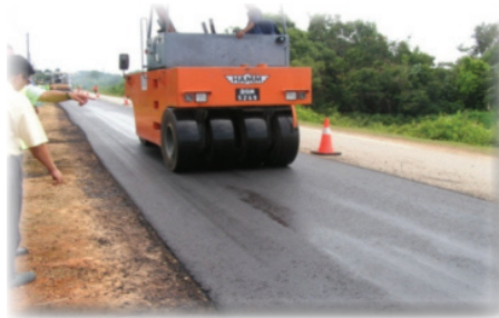
Penggunaan penggelek tayar pneumatic TIDAK dibenarkan dalam pepadatan porous asphalt.
