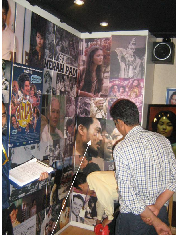
Pintu kabinet papan suis utama yang dilekatkan dengan gambar.
