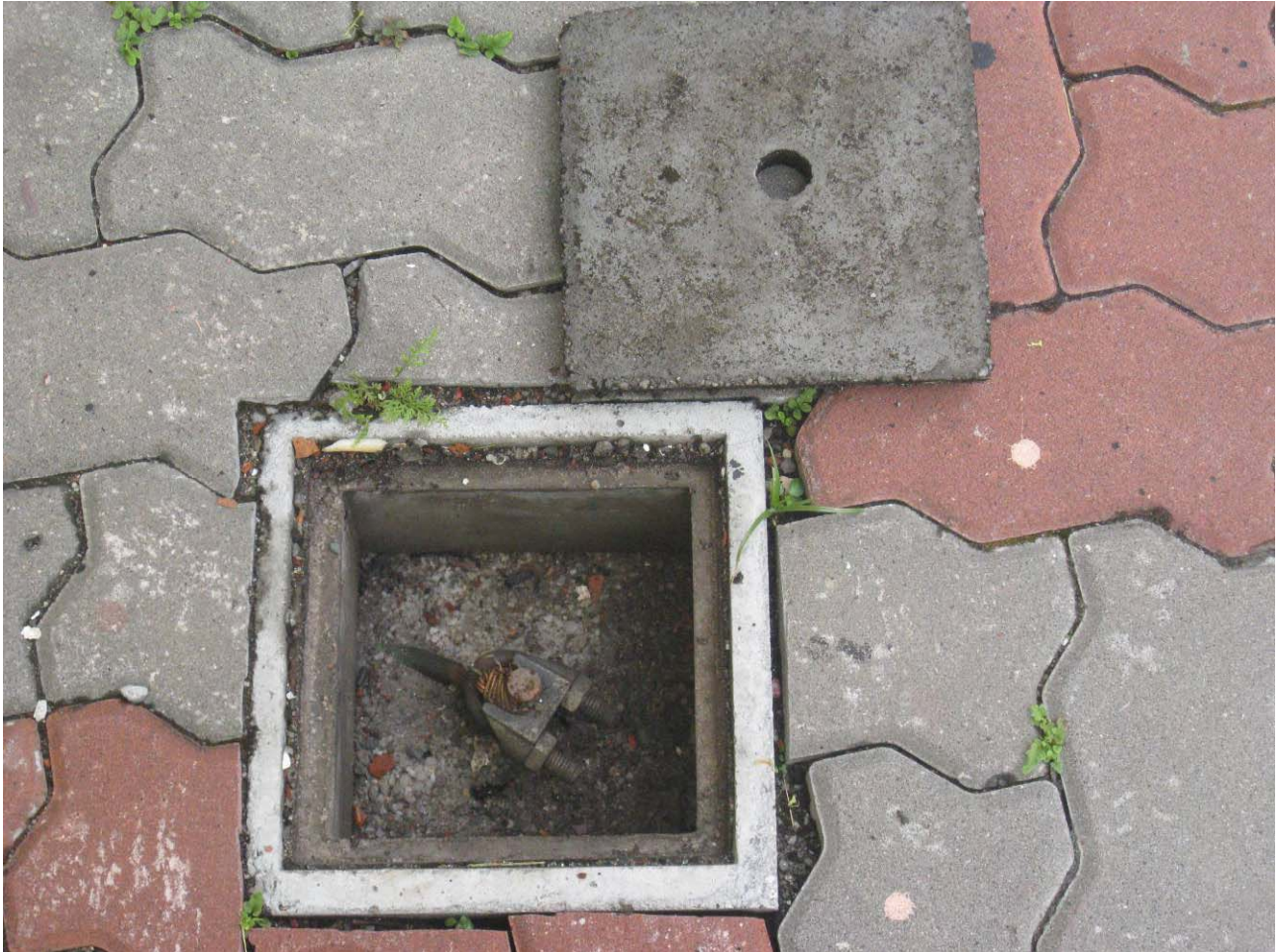
Kaedah sambungan menggunakan 'clamp'.
