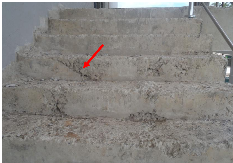
Gambar 8 : Honeycomb pada tangga
