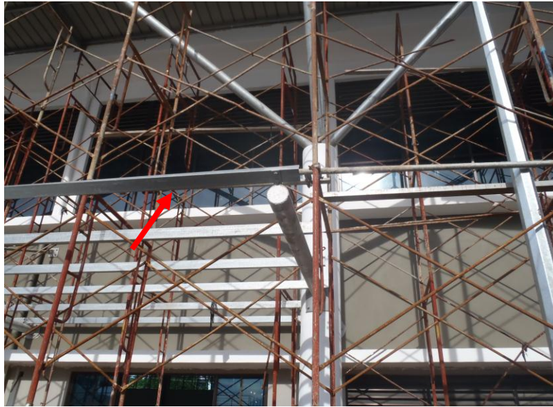
Gambar 7 : C Channel kuda bumbung yang bengkok
