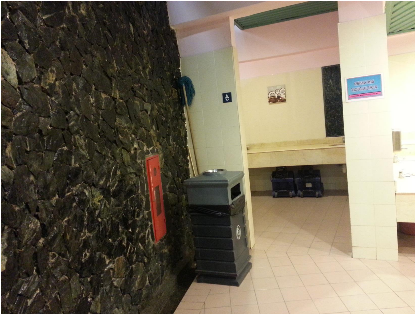
LOKASI FIRE EXTINGUISHER – LALUAN TANDAS
