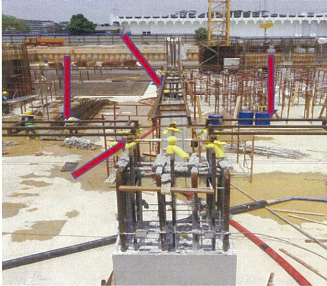
Pemasangan Control Frame & Plate
