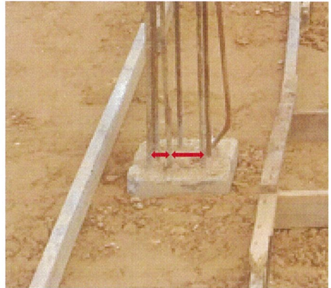
Jarak antara starter bar tidak konsisten
