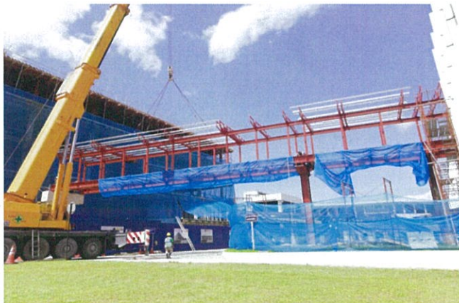
Pemasangan struktur link bridge di atas pile head
