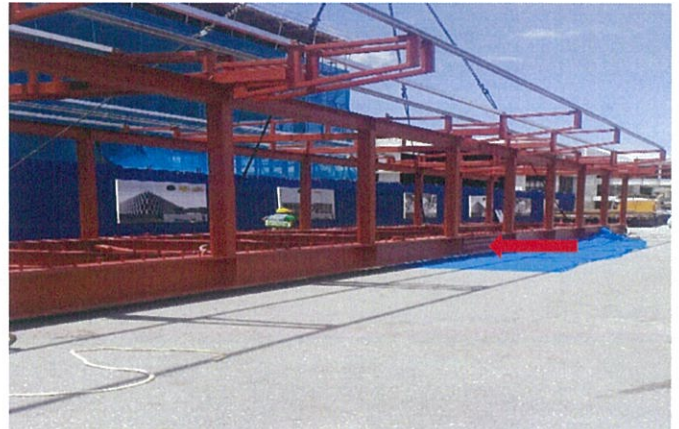
Penyambungan 2 span link bridge
