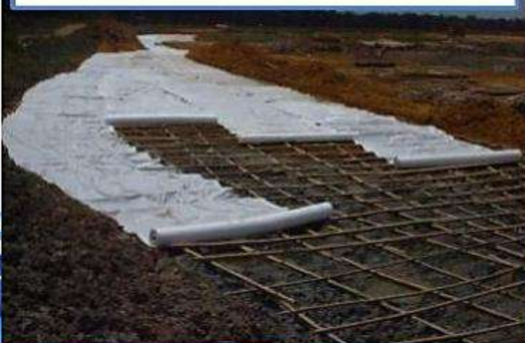
Laying Geo-membrane
