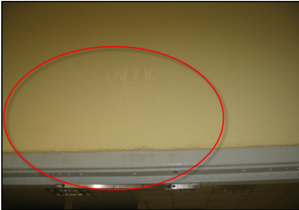
Gambar 4: Berlaku kondensasi diantara dinding ruang legar forensik dan Bilik Autopsi (Islam) .
