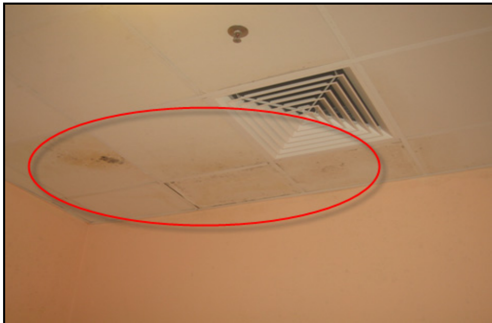
Gambar 16: Kulat juga terbentuk pada bahagian permukaan siling.
