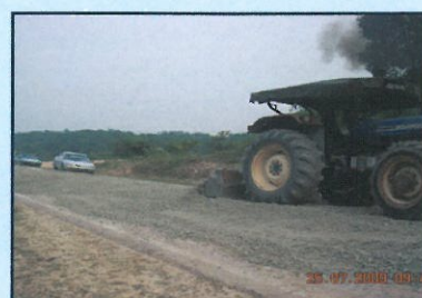
100mm crusher-run ditambah pada lapisan sedia ada.
