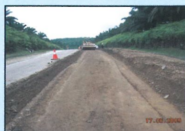
Lapisan crusher-run dipadatkan.
