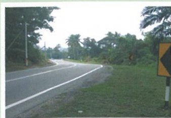
Manjung sebelum pembaikan.
