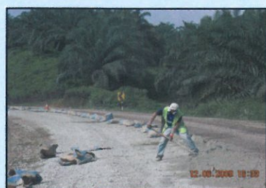
Kerja menabur simen secara manual dijalankan.
