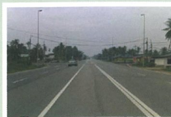
Kuala Selangor sebelum pembaikan.
