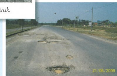
Permukaan jalan berlubang-lubang.
