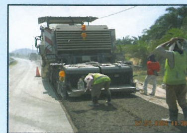
Lapisan 100mm crusher-run dikitar bersama struktur sedia ada dan simen setebal 250mm.
