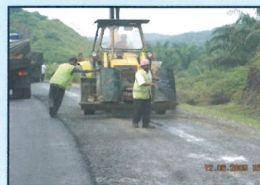
Kerja semburan lapisan prime coat-SS1K.
