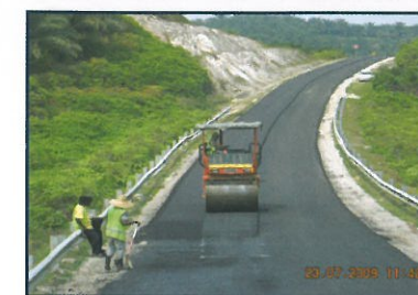
Kerja-kerja memadat lapisan ACWC.
