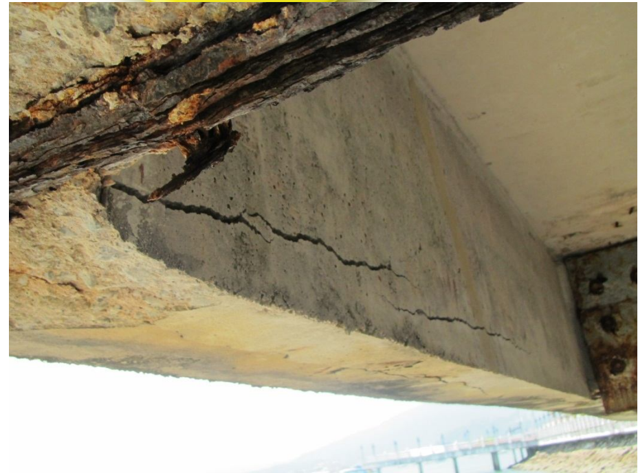
Retak pada rasuk di sebuah jeti. Pengaratan disebabkan ion klorida dari laut
