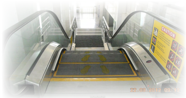
Pandangan dari top landing floor
