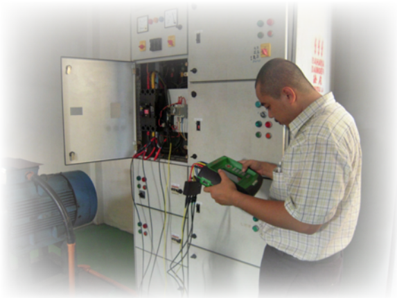
Mengambil bacaan penggunaan elektrik bagi sistem mekanikal menggunakan Power Meter
