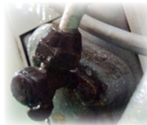
Kesan berminyak pada service valve
