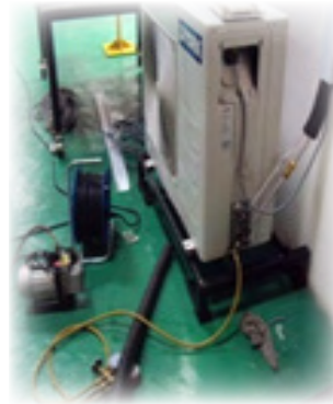
Pemasangan Paip Aluminium
