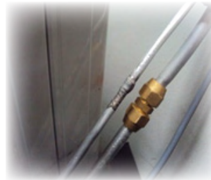
Sambungan Jenis Flaring dan Welding
