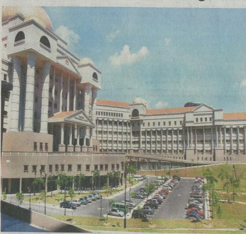
MASALAH BERULANG: Kompleks Mahkamah Kuala Lumpur di Jalan Duta.
