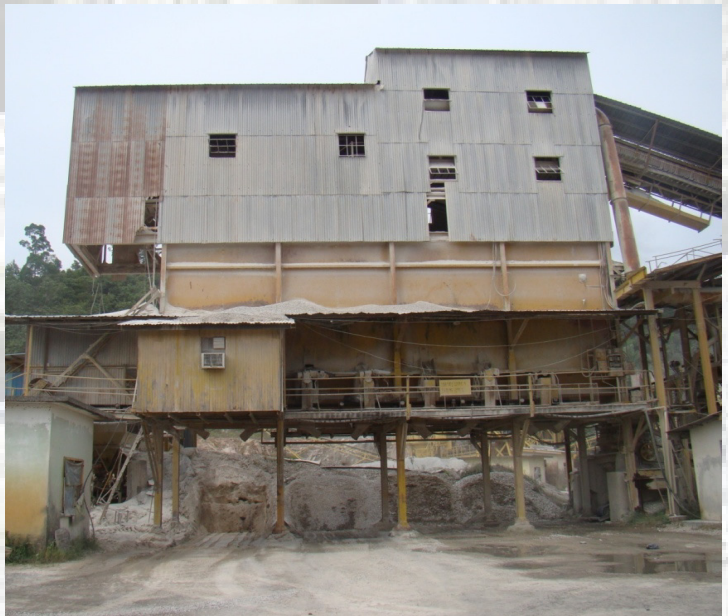
Grading Bunker sebelum naik taraf
