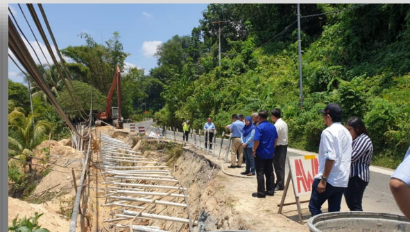
Lawatan Tapak bersama JKR Sabah & JKR Sandakan di Sandakan
