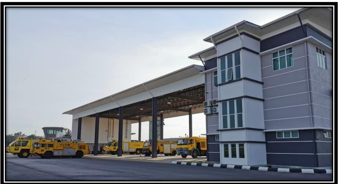
Gambar 2.1 : Bangunan Kompleks Bomba
