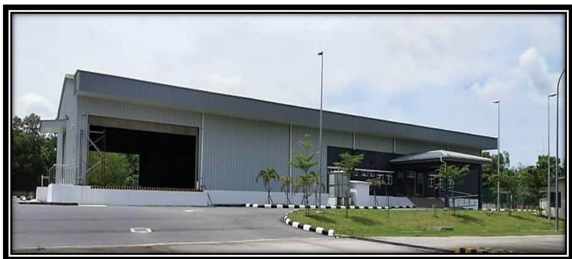
Gambar 2.8 : Bangunan Stor Matra
