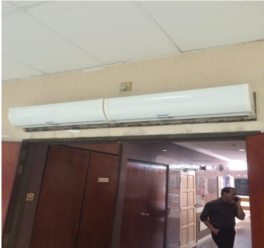
Rajah 17: (a) Air Curtain diantara Lobi dan Kafe & (b) Air curtain diantara lobi dan parkir.
