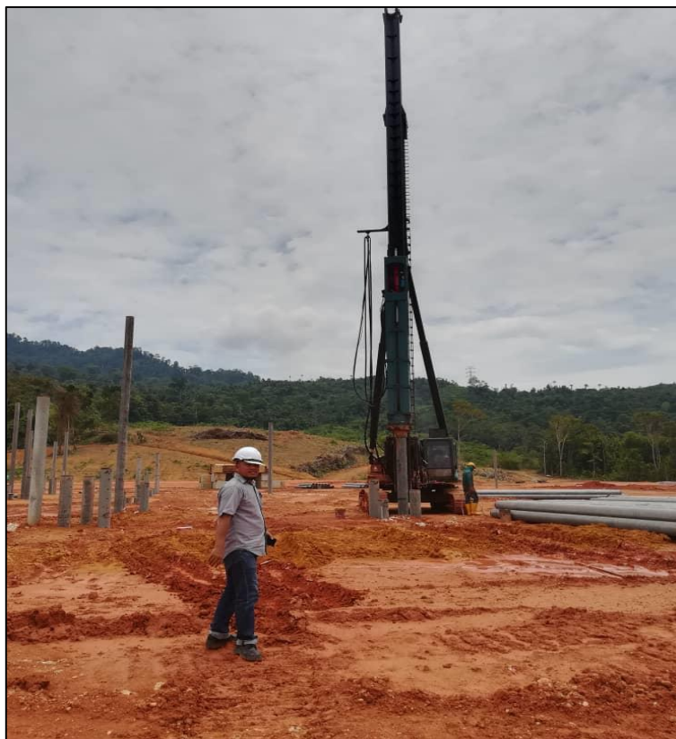
Gambar 2 : Kerja -Kerja Penanaman Cerucuk (Piling)
