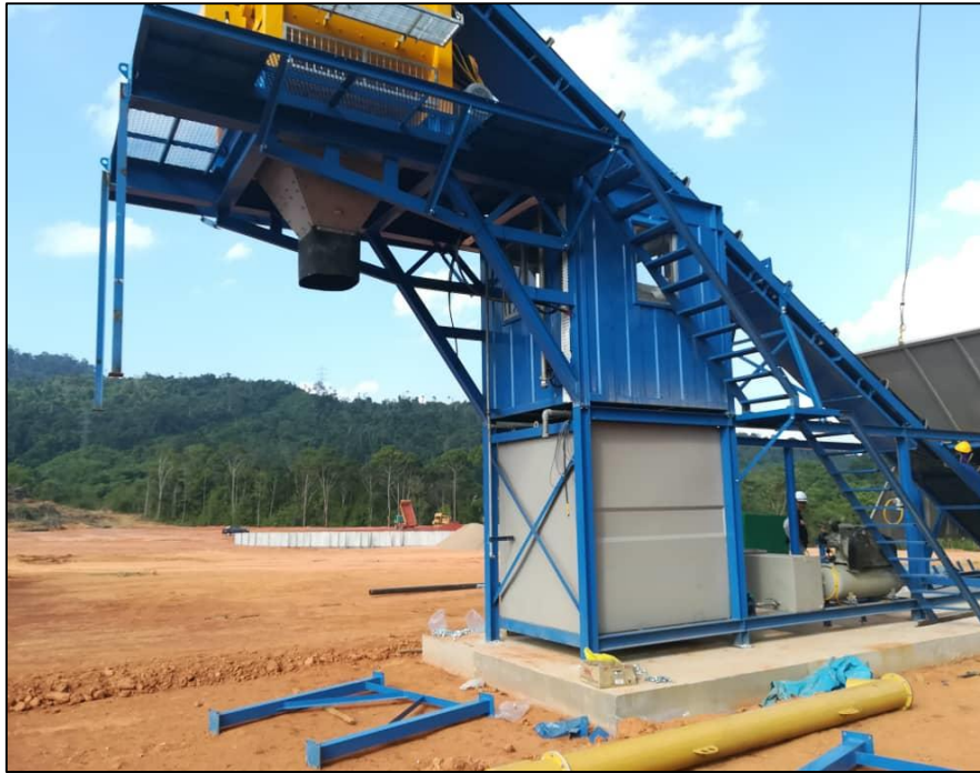
Gambar 3 : Pemasangan Batching Plant di tapak bina
