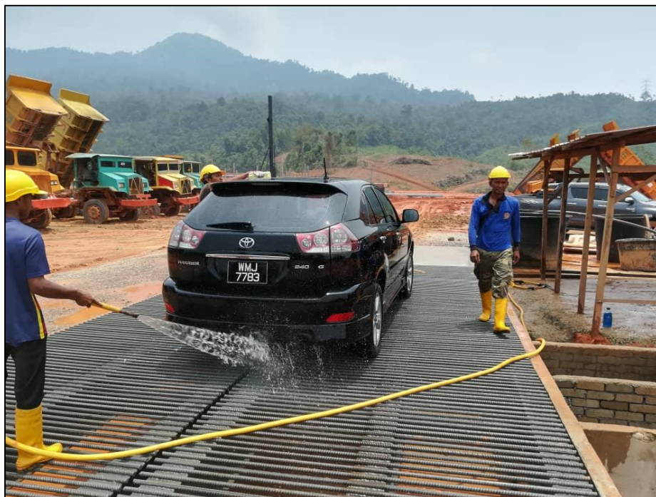
Gambar 4 : Pemasangan Wash Bay yang siap beroperasi.
