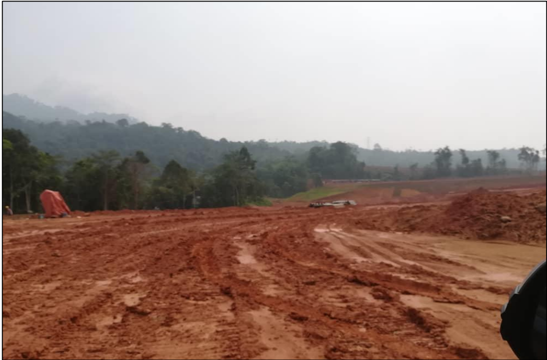
Gambar 1 : Kerja – kerja Pembersihan Tapak (Site Clearing)
